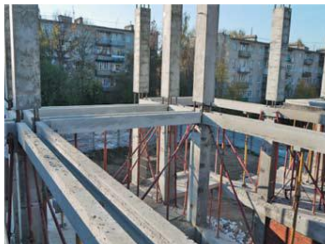
Рис. 2. Связевые ригели, выступающие на потолке квартир
