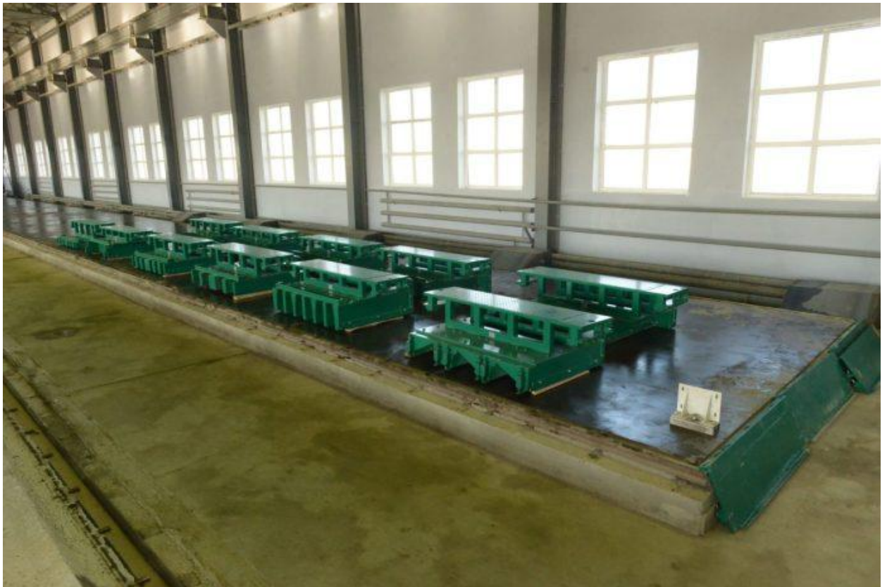
Рис. 21. Цех КИС в г. Актау, производительностью до 100 000 м 2 жилья в год. Стенд для изготовления колонн и элементов каркаса дома. На стенде — пресс-формы для изготовления плит перекрытий, ступеней, перемычек и других ЖБ изделий для каркаса дома
